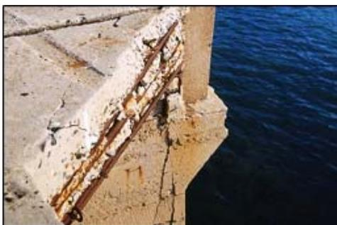
Alternativas de solución: Uso de lechada con aditivos como la resina epóxica o solamente lechada de cemento para el recubrimiento de las armaduras expuestas al aire;
