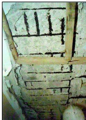
Causas principales: (i) presencia de aguas sulfatadas y (ii) infiltraciones a través de vacíos o hendiduras en las estructuras del concreto.
